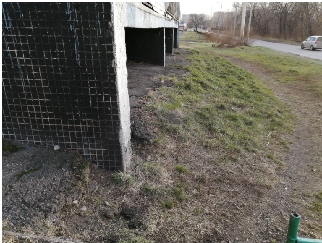
Рис.№3. Состояние отмосток.
